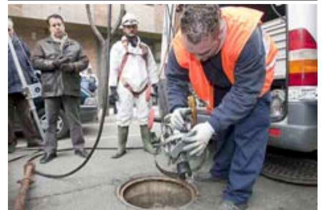
Instalación de fibra óptica en el alcantarillado. DANIEL MARCOS
