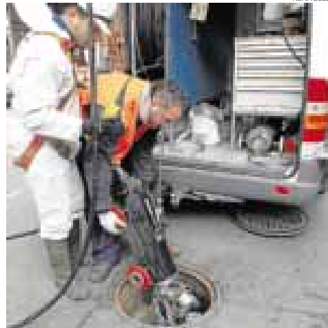
▶▶ Al subsuelo ▶ Los operarios meten el robot en el alcantarillado.
